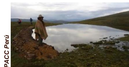
En el Altiplano, especialmente en Perú y Bolivia, se construyen qochas o lagunas artificiales que actúan como reservorios de agua. Este sistema permite almacenar agua durante la temporada de lluvias para utilizarla en la época seca.
